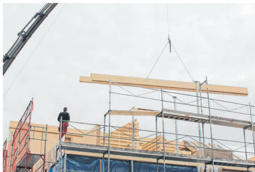
Jürgen Metzler bringt Elementhaken an, damit die vorgefertigten Teile – die größten davon sind mehr als drei Tonnen schwer – vom Kran an Ort und Stelle gehievt werden können.
