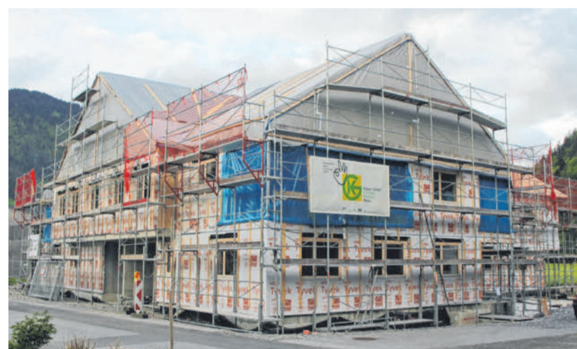
Wo in der Bezauer Parzelle Ellenbogen vor wenigen Monaten noch ein über 200 Jahre altes Bauernhaus stand, wird in gleichen Umrissen ein neues Gebäude erstellt. STP(2)
